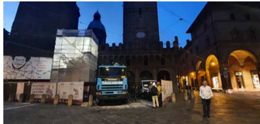
▲ Fig. 2. Il cantiere notturno.
