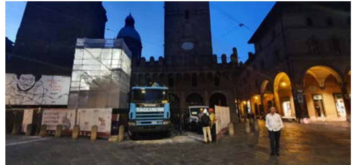
▲ Fig. 2. Il cantiere notturno.
